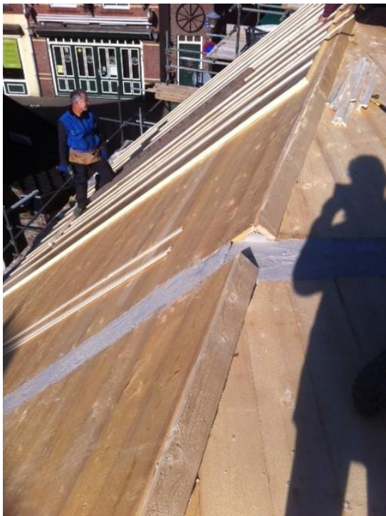
Foto: J.G. Selen, Tussen de bouwdelen wordt een onderbreking gemaakt van mortel en steenwol om evt brandoverslag te vertragen. Heb binnenkort een afspraak met de brandweer...altijd weer spannend om een bestaand monument toch zo goed mogelijk brandvertragend te krijgen. Wordt vervolgd.
