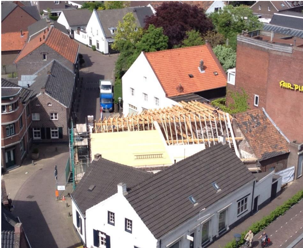
Roy Denessen van de Gemeente Venlo maakt op gezette tijden foto's vanaf de Martinustoren. Hier is goed de vordering te zien. Nieuwe muurplaten; gordingen; sporen en het dakbeschot worden met grote zorgvuldigheid en met oude en nieuwe verbindingstechnieken aangebracht.
