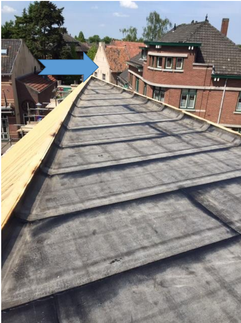
Foto: M. De Groot. Het platte dak gedeelte is weer waterdicht. Met vooraan bij de punt van het dak, er tegenover het grote voorbeeld: Het Kranenbreukershuis, welke er voor met steun van de Provincie Limburg en Gemeente Venlo gerestaureerd kon worden.
