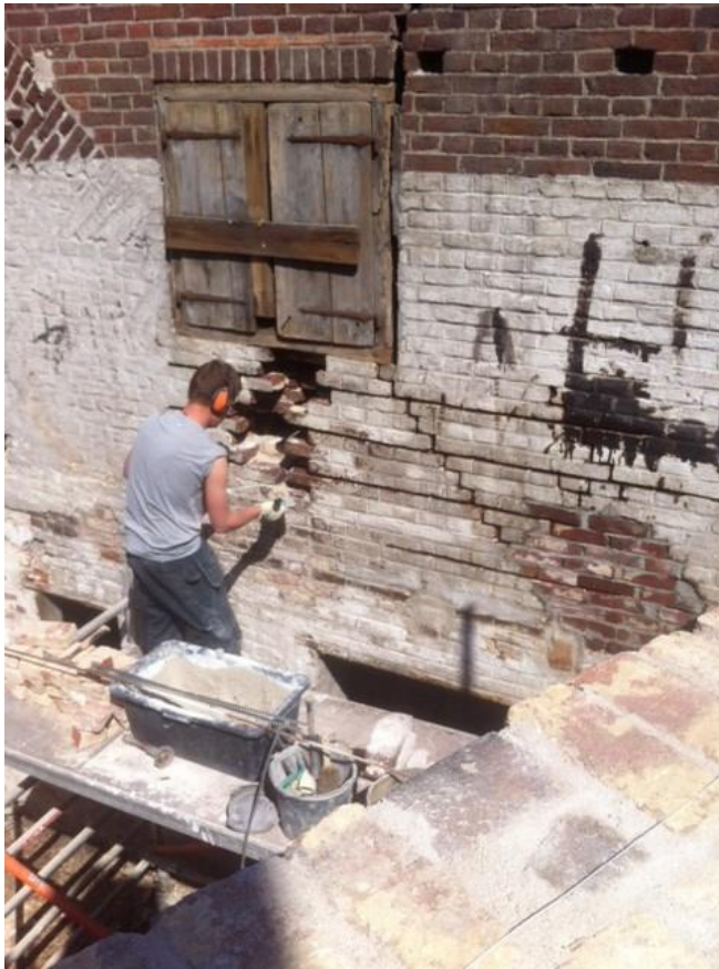
Alle scheuren zijn opgehakt en ingeboet of voorzien van rvs “wokkels”: een soort trek en verbindingsslangen om losgescheurd metselwerk onderling te koppelen. Hier door Leerling metselaar Roy Cox (via Fundeon/ ROP) aangebracht.
