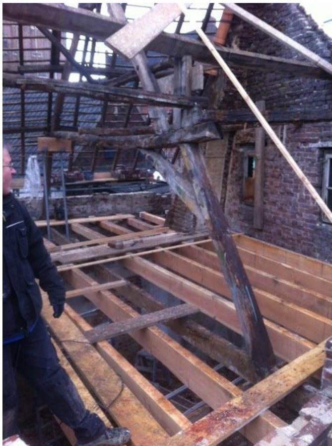
De 1 e verdiepingvloer werd eerst vervangen om stabiliteit van de gevels te waarborgen en een goede werkvloer te creëren.
