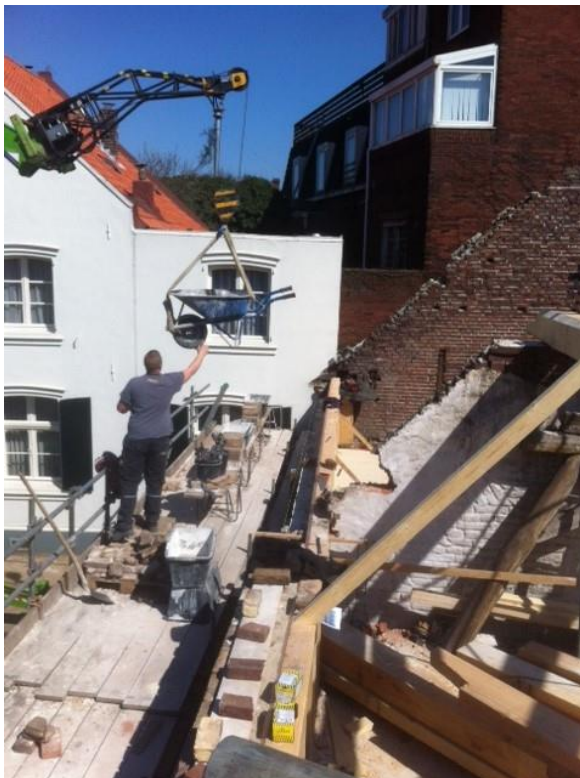
Ondanks de beperkte bouwplaatsruimte kan een kraan hierop plek vinden en een grote hulp zijn.
