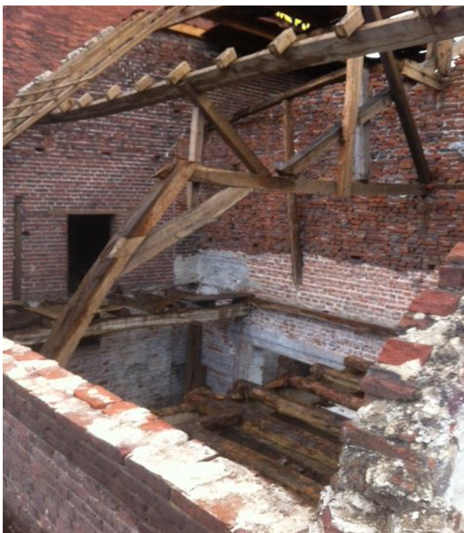
Oude balken worden stuk voor stuk beoordeeld of ze (evt. elders) hergebruikt kunnen worden. Voor het grote dakvlak blijken er te weinig oud hout te handhaven. Alles wat toch over blijft zullen we hergebruiken op het dak van het Brouwerij gedeelte.
