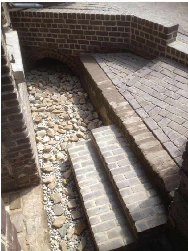
Een stoep/trap over de Engerbeek, die nu weer een functie heeft. Het grind vangt een deel van het regenwater op, welke bezinkt in de grond.
