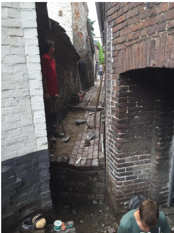
Hier dus in de richting van de St. Martinusstraat gekeken (het hekwerkje is hier nog niet geplaatst). Al het regenwater van de daken van Brouwerij/Stijfselfabriek en het pand aan de Grotestraat 44 wateren af op de molgoot. Dit water gaat straks de weer te openen wasplaats (fase II) voorzien van water ten tijde van regenval.
