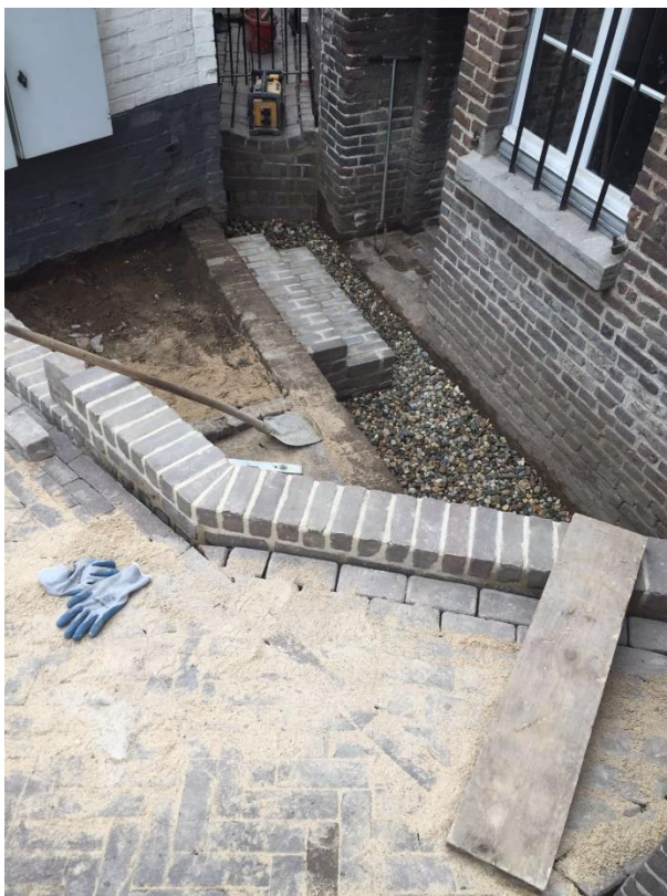
De doorgang rechts is weer geheel vrij en op oorspronkelijke hoogte uitgegraven. Het grind is de hoogte van de vroegere waterlijn. Het hekwerkje geeft nu een doorzicht naar de andere kant (waar eerst een muur stond)
