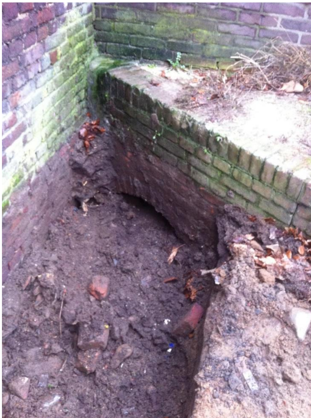
Een stukje van de overkluizing van de Engerbeek, onder de Grotestraat kwam in het zicht.
