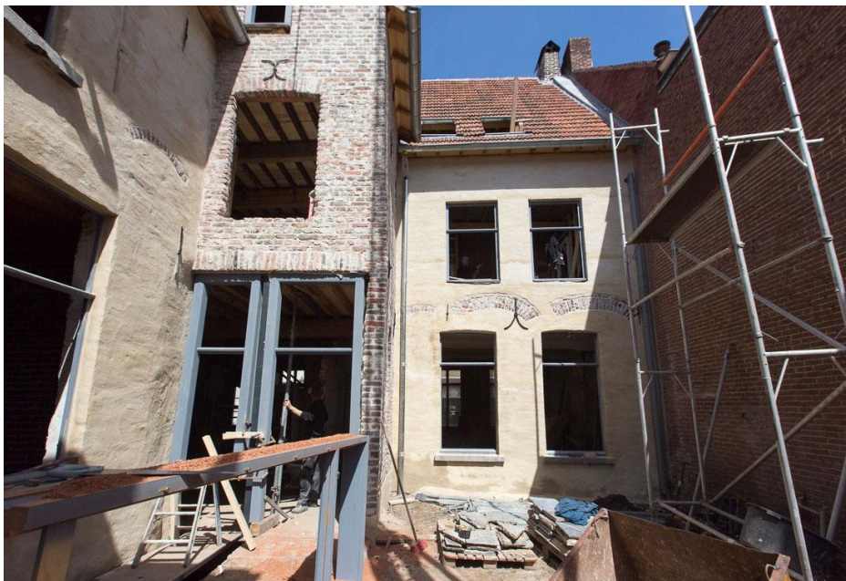
Op de grote binnenplaats worden intussen de kozijnen en ramen herplaatst. Daarbij komen ook constructieve verbeteringen aan de orde. Diverse staalwerken worden onzichtbaar geïntegreerd in kozijn en muurwerk.
