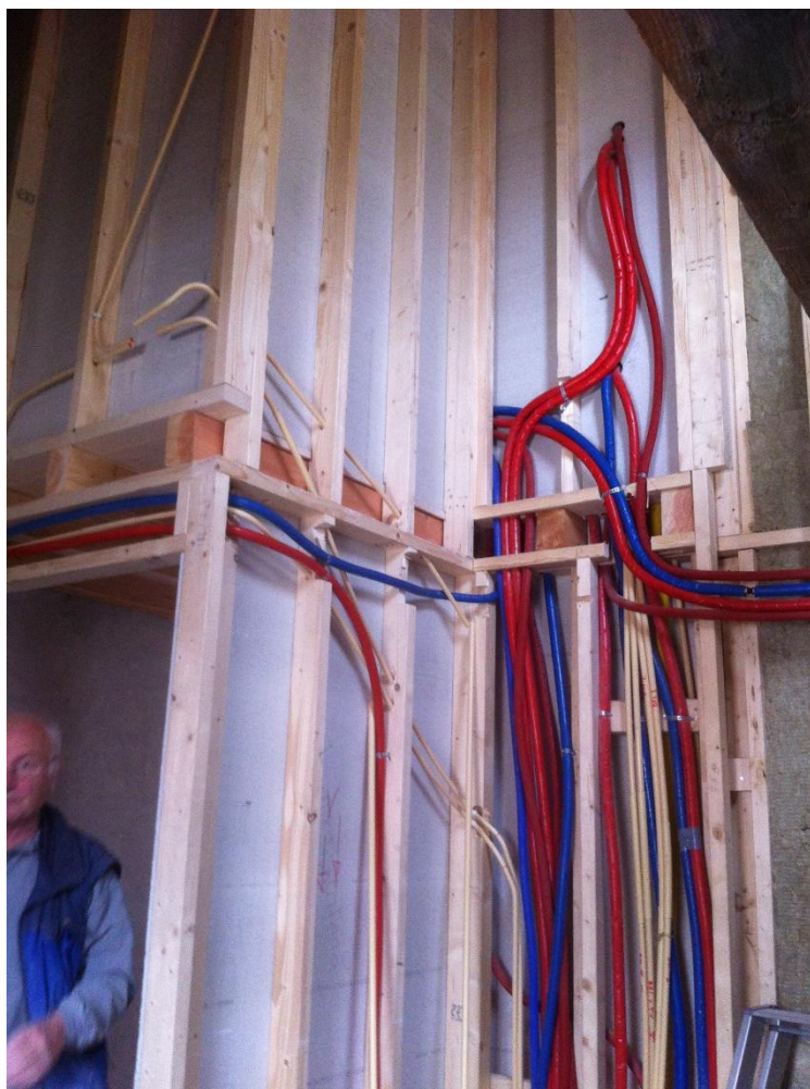
Binnen wordt ca. 2 kilometer warm en koudwaterleidingen en cv. Leidingen weggewerkt in de lichte tussenwanden. In de brandwerende wanden tussen trappenhuisen en wanden worden zo min mogelijk leidingen verwerkt of er wordt een extra Fermacellaag aangebracht.
