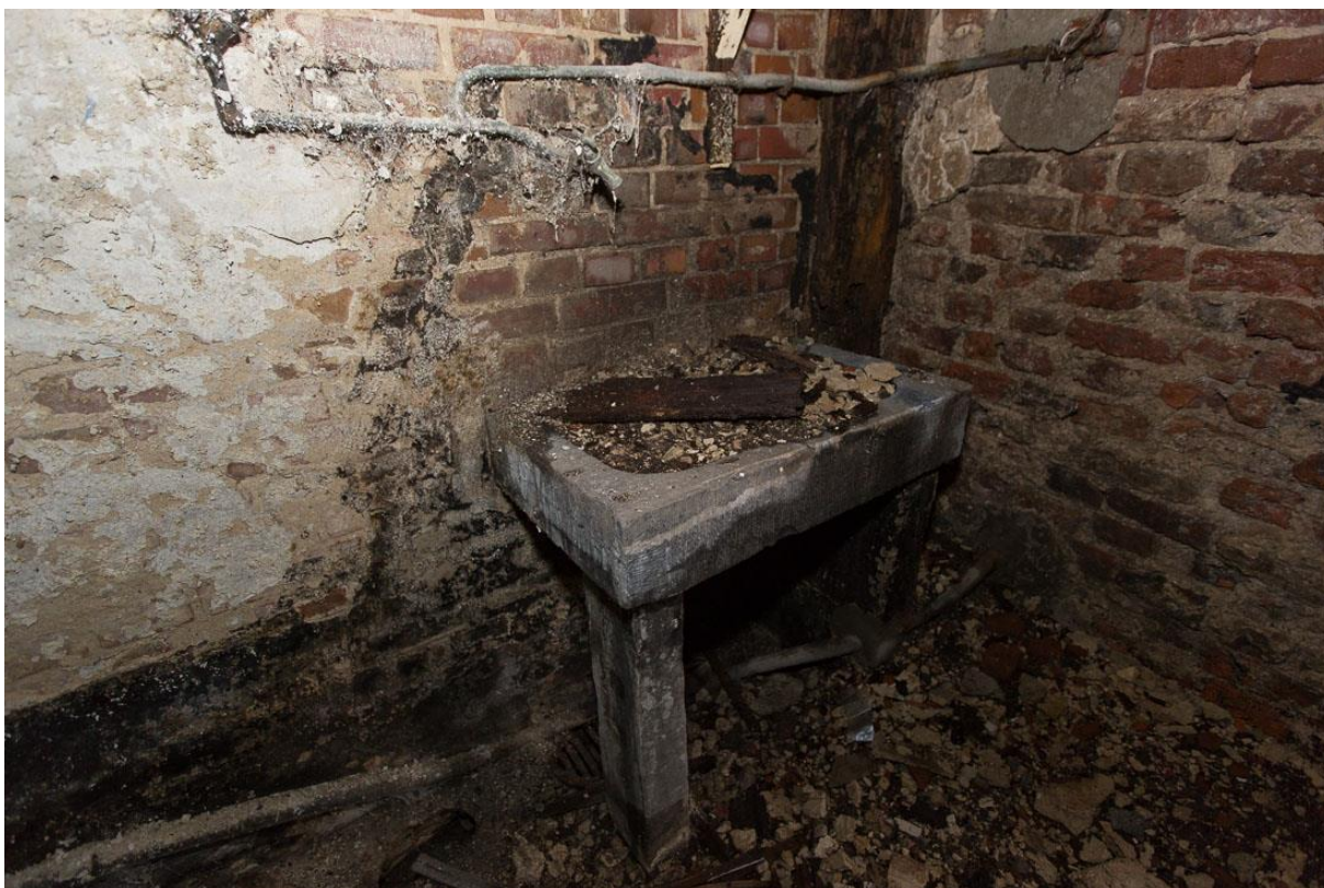
Het hardsteen wasbakje in het achterhuis....werd herplaatst.
