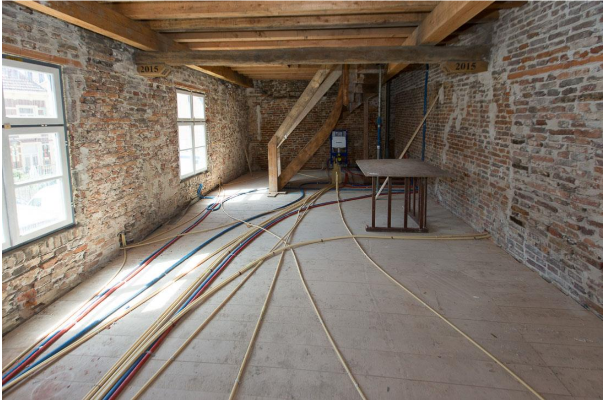
Binnen werden de woning-scheidende vloeren voorzien van Fermacell korrelvloeren en Fermacell geluidsisolerende platen vloeren. Er onder, op de constructievloer een deel van het leidingwerk.
