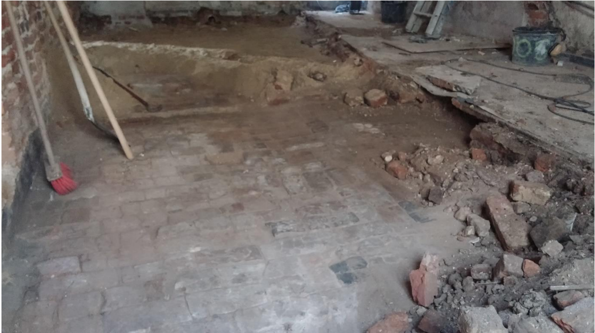
Baksteenvloeren werden ontdekt in Houtstraat 11. Deze vloer is deels blijven liggen en afgedekt met een folie, waarop een nieuwe cementdekvloer is gestort. Hierin liggen dan de elektra en verwarmingsbuizen.
