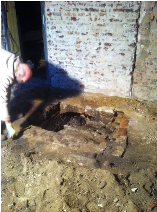
Door Bart Klück en Birgit Dukers van Buro4 werd diverse keren bouwhistorisch onderzoek tijdens de restauratie uitgevoerd. Een geheel herziene rapportage is in de maak. Hier is Bart Klück een gevonden Beerput vrij aan het leggen die is gesitueerd onder de muur die tussen de puddingruimte en achterste ruimte aan de Ariensplaats is gelegen. De put is ingemeten en gedicht met gestabiliseerd zand en afgedekt onder de cementdekvloer.
